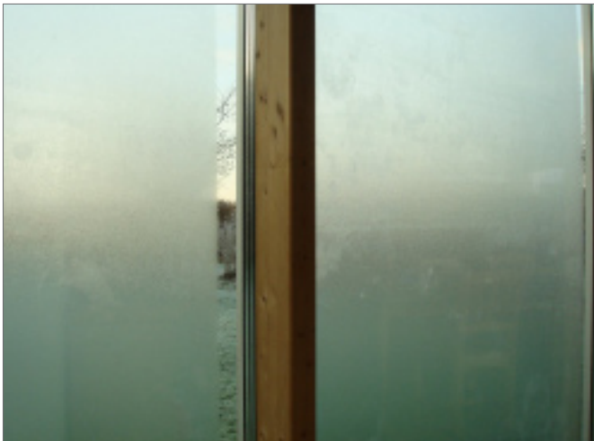
13. 1. 2008, 09:32 Uhr: Die Außenfläche der Verglasung ist nahezu komplett zugefroren. Im Bereich der Glasrandzone reicht der höhere lokale Wärmeverlust aus, um nach draußen blicken zu können.
